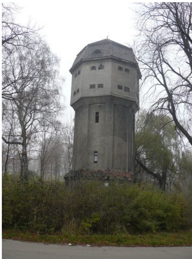
Ilustracja 59: Wieża wodna w zespole dworcowym.
